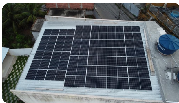
Projeto Residencial 15,00kWp - 40 Módulos Serra - ES
