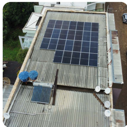
Projeto Comercial 13,78kWp - 26 Módulos Irupi - ES
