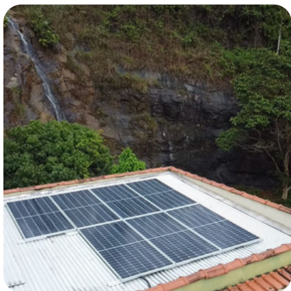
Projeto Residencial 3,15kWp - 07 Módulos Guaçuí - ES
