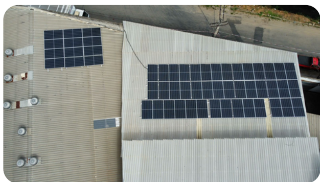
Projeto Industrial 27,00 kWp - 54 Módulos Cariacica - ES
