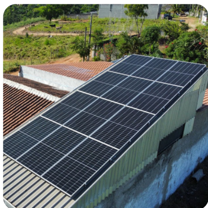
Projeto Residencial 6,54kWp - 12 Módulos Serra - ES
